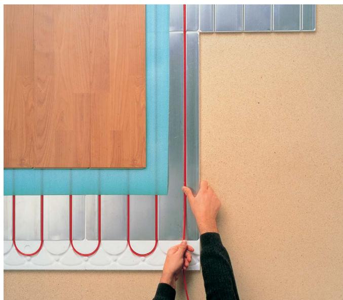
Le système de chauffage par le sol Reflecta/T2Red se compose de plaques isolantes Reflecta et d'un câble chauffant autorégulant T2Red.
