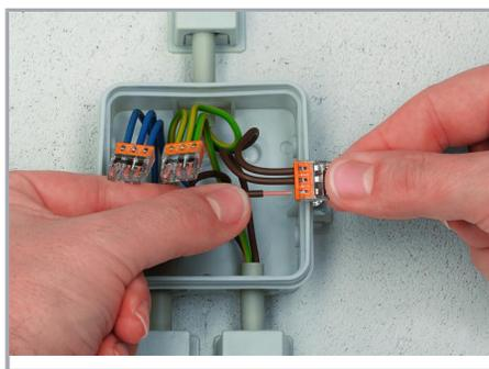
Pour raccorder : introduire le conducteur rigide dénudé jusqu'en butée.
