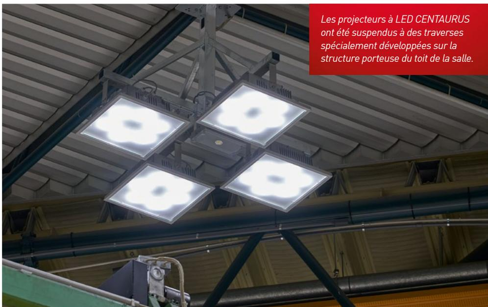
Les projecteurs à LED CENTAURUS ont été suspendus à des traverses spécialement développées sur la structure porteuse du toit de la salle.
