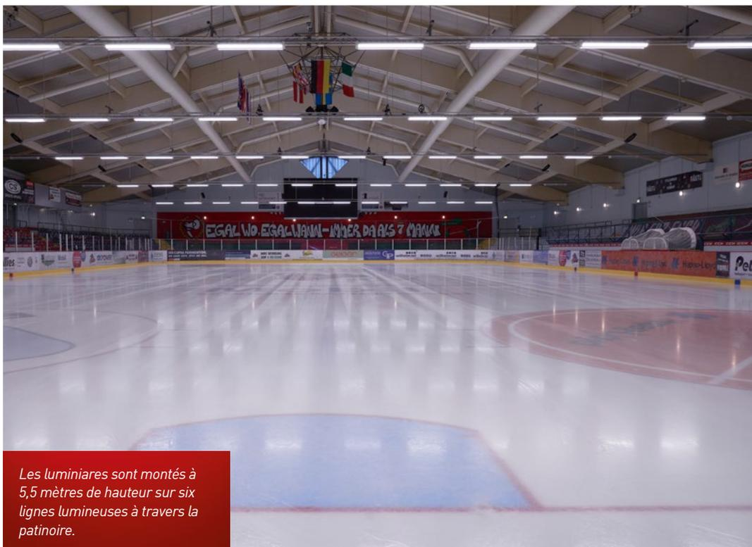
Les luminaires sont montés à 5,5 mètres de hauteur sur six lignes lumineuses à travers la patinoire.
