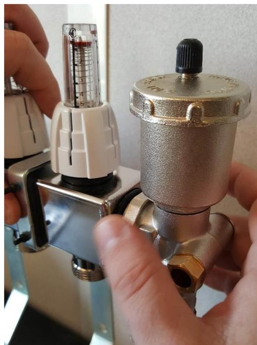
Engager l'écrou de serrage sur le filet puis utiliser une clé pour venir comprimer le joint tout en maintenant le module de purge en position verticale avec une contre-clé.
