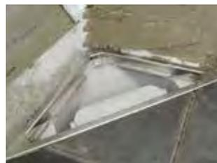
**6** Coller le carrelage et la faïence. Veiller à ce que le carrelage soit affleurant du cadre. Ce dernier est scellé grâce au carrelage et à la colle.
