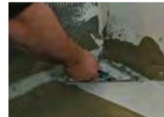
**4** Couper soigneusement au cutter la partie de la natte d'étanchéité couvrant l'intérieur.
