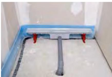
**5** Coller le tube d'évacuation en diamètre 40 mm à la sortie (femelle) du caniveau de douche.
