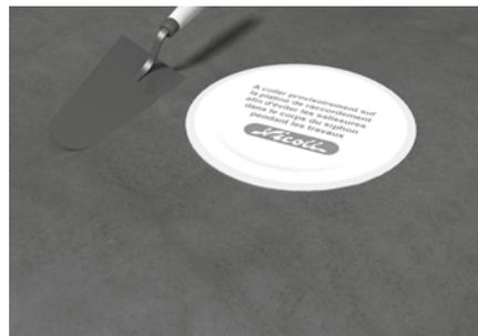
**4** Coller le film protecteur sur le corps du siphon. Réaliser une chape, puis lisser jusqu'au niveau de la platine.
