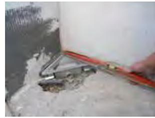
**2** Positionner le siphon sur la platine. Régler la hauteur et l'inclinaison du siphon à l'aide d'un niveau et en fonction de l'épaisseur du carrelage.
