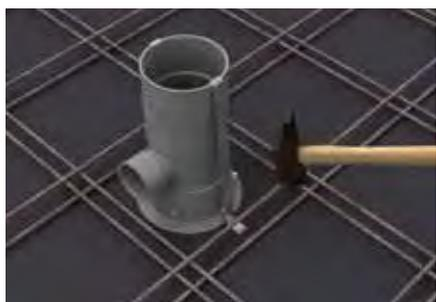
**5** Clouer l'embout de coffrage Ø100 au plancher.
