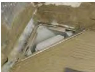
**5** Placer le cadre INOX sur les cales précédemment positionnées et appliquer la colle à carrelage.
