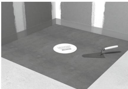
**2** Coller le film protecteur sur le corps du siphon. Comblar la réservation avec du béton dans la gorge prévue à cet effet, et raser à la hauteur du siphon sans son joint.
