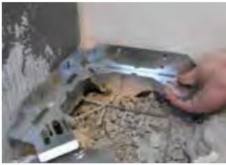
**1** Pour faciliter positionner votre siphon d'angle DOCIA : Marquer, percer et pré-fixer la platine au mur.
