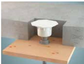
**2 3** Placement du siphon & scellement au mortier rapide.
