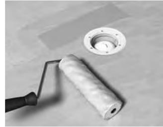
**3** Pose d'une étanchéité liquide sur la platine préalablement bridée sur le corps de siphon (nécessaire pour ce type de pose).
