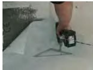
**2** Apposer et maroufler la natte d'étanchéité sur la colle, y compris sur le siphon d'angle, puis fixer la bride avec les vis fournies.
