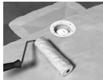
**3** Pose d'une étanchéité liquide sur la platine préalablement bridée sur le corps du siphon.
