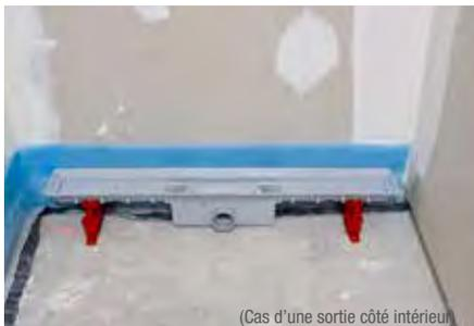
**2** Plusieurs positions sont possibles suivant que l'on souhaite se coller contre le mur, avec la sortie côté mur ou avec la sortie côté intérieur.
