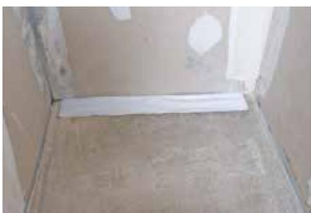
**6** Coller l'autocollant de protection sur le caniveau puis réaliser la chape avec une pente de 1 cm/m minimum
