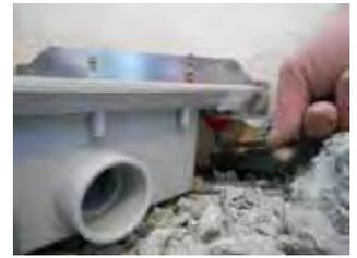
**3** Décaler le siphon des murs en fonction de l'épaisseur de la faïence et de la colle puis verrouiller la position du siphon en fixant les vis sous le corps grâce à une clé Allen.
