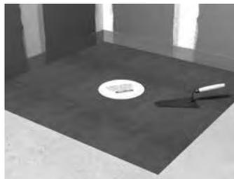
**2** Coller le film de protection. Réaliser la chape avec une forme de pente de 1 % minimum, comblar la dalle.
