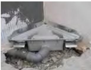
**4** Coller le tube d'évacuation en diamètre 40 mm à la sortie femelle du siphon d'angle.
