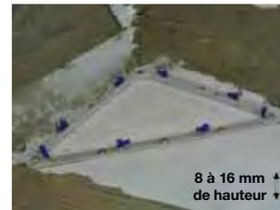
**3** Choisir et positionner les cales (bleues/rouges) pour ajuster la hauteur du cadre et de la grille à la hauteur du carrelage (6, 8, 10, 12, 16 mm)
