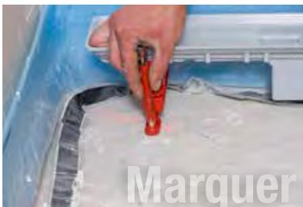
**3** Positionner le caniveau à l'emplacement désiré. Marquer, percer et fixer le au sol.
