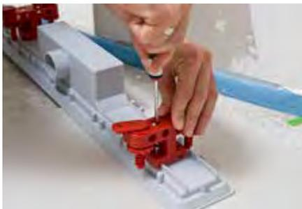
**1** Fixer les pieds réglables au corps du caniveau, en fonction de la position du caniveau par rapport au mur.
