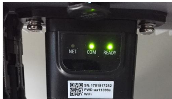
Figure 72 – État initial des LED
