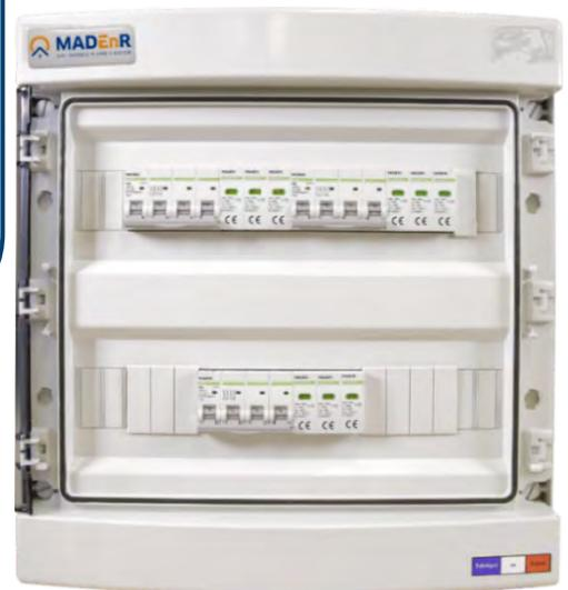
Figure 19 : Coffret 3MPP non équilibrés – 1000 V
