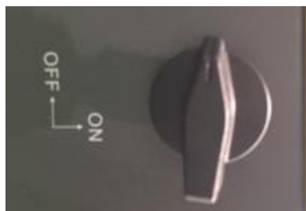
Figure 48 – Sectionneur photovoltaïque
