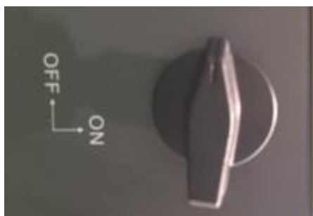
Figure 48 – Sectionneur photovoltaïque
