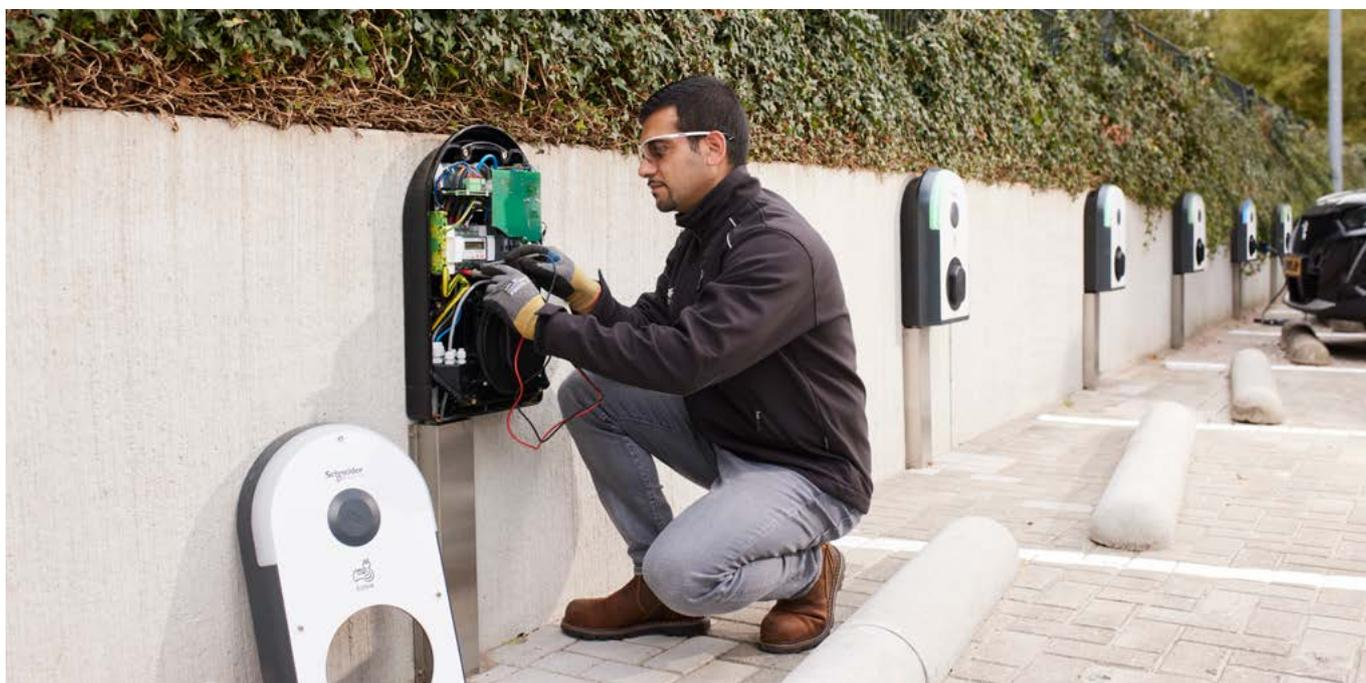
Avec ses protections intégrées la borne EVlink Pro AC permet de gagner du temps d'installation ainsi que de la place dans le tableau divisionnaire.
