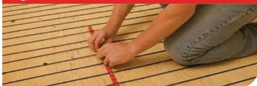
Pour faciliter l'installation des "guides de stabilisation des câbles", retournez le guide de câble à l'envers pour le faire passer en douceur sous les câbles. Retournez ensuite les guides pour les fixer au sol et mettez les câbles en place.
