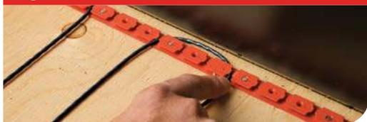
Les guide-câbles peuvent être fixés au support à l'aide de vis, de clous, d'agrafes ou de colle thermofusible. En cas d'utilisation de vis, de clous ou d'agrafes, utiliser 3 à 4 vis, clous ou agrafes par guide-câbles.
