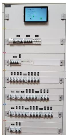
L'afficheur **PE-TAB** permet de se connecter aux centrales Power-Elec en Wifi pour les configurer et visualiser les données instantanées des départs mesurés.
