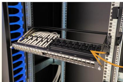
Grâce à son système de support de câble arrière, le panneau de brassage Keystone GIGAMEDIA vous permet d'optimiser vos temps d'installation, en facilitant le peignage des câbles et en favorisant la gestion des rayons de courbure.
