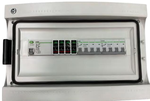
Figure 37 : Photo coffret AC TRI 2 arrivées micro-onduleur réf. 23201820
