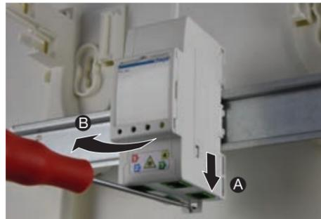
Tirer le clip rail DIN vers le bas (A) puis basculer le DTIO vers l'avant (B).
