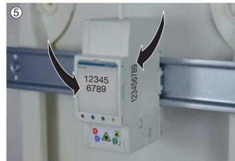
Identifier le DTIO : coller l'étiquette d'identification dans la zone prévue à cet effet sur le côté et reporter ces informations sur l'étiquette en face avant.
