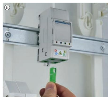
Effectuer des mesures de contrôle en connectant un cordon optique sur la sortie du DTIO. Connecter ensuite la sortie du DTIO sur l'ONT de la Box Internet.
