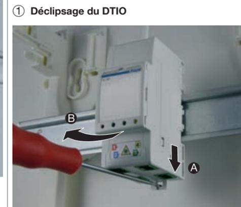
Tirer le clip rail DIN vers le bas (A) puis basculer le DTIO vers l'avant (B).
