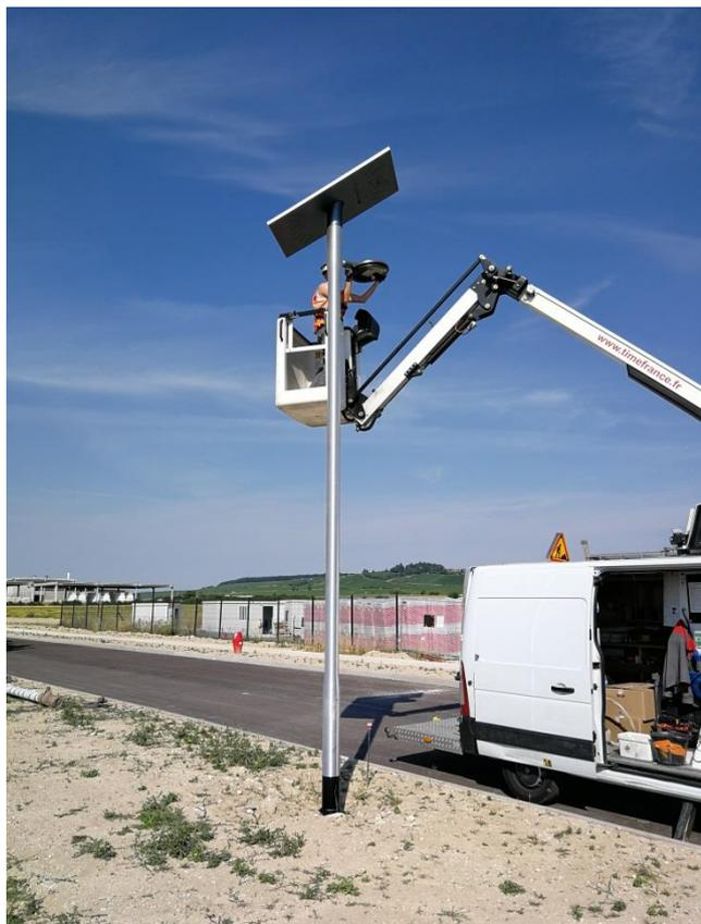
Si le levage du mât a été réalisé avec tous les éléments en place, une petite nacelle suffit à faire en fin de pose le réglage de l'horizontalité du luminaire et de l'orientation (plein sud) du panneau solaire.
