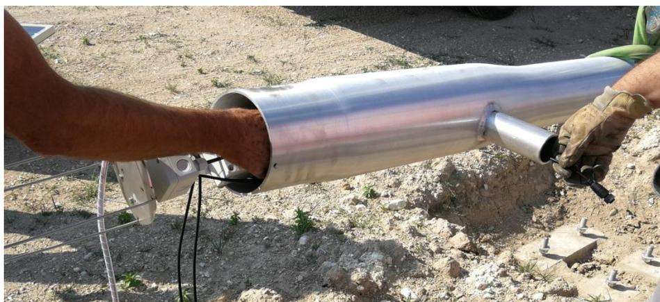
Note : dans certains cas il peut être plus simple de poser d'abord le luminaire en faisant dépasser son câble vers le haut du mât, avant de brancher celui-ci et de placer l'ensemble boîtier de gestion + panier de batterie dans le mât (cf. photos ci-dessous avec un modèle de luminaire équipé de la connectivité Sigfox).
