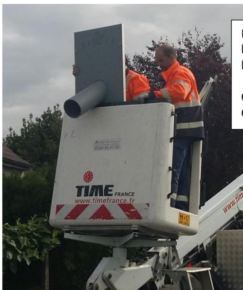
Placer les 8 vis de pression (livrées) de fixation du panneau. Si possible, les vis doivent être enduites de colle frein-filet démontable (Loctite bleue ou équivalent).
