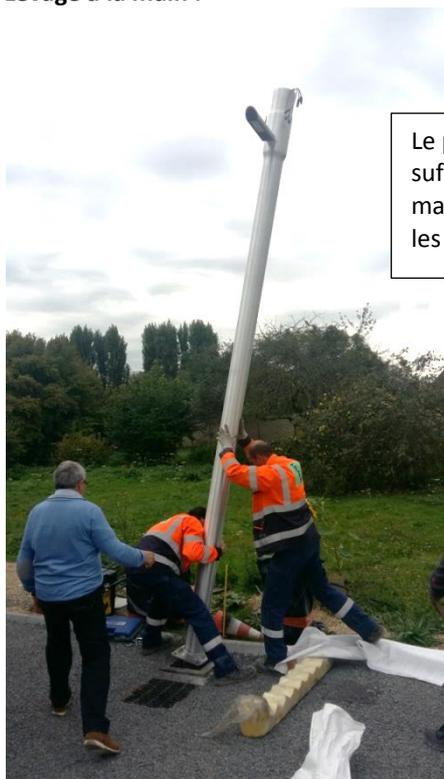
Le poteau en aluminium est suffisamment léger pour être levé à la main, en bloquant la base du mât sur les tiges du massif.
