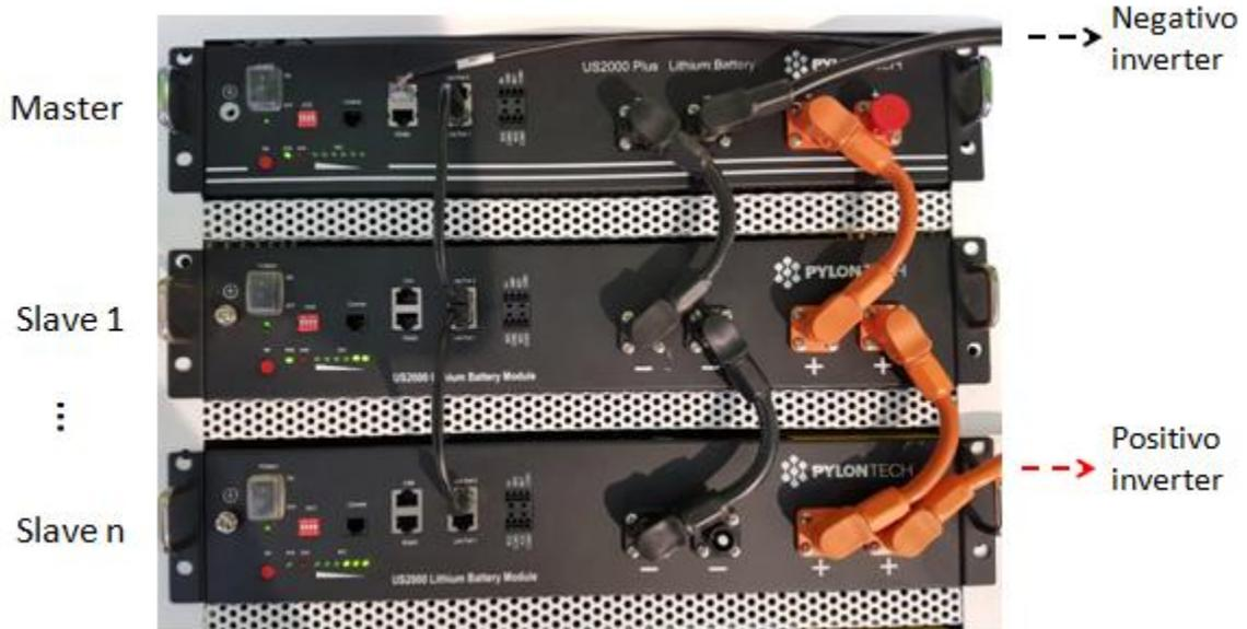
Figure 1 – Raccordement de trois batteries Pylontech en parallèle
