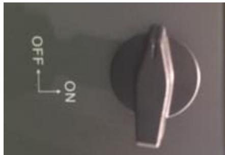
Figure 48 – Sectionneur photovoltaïque
